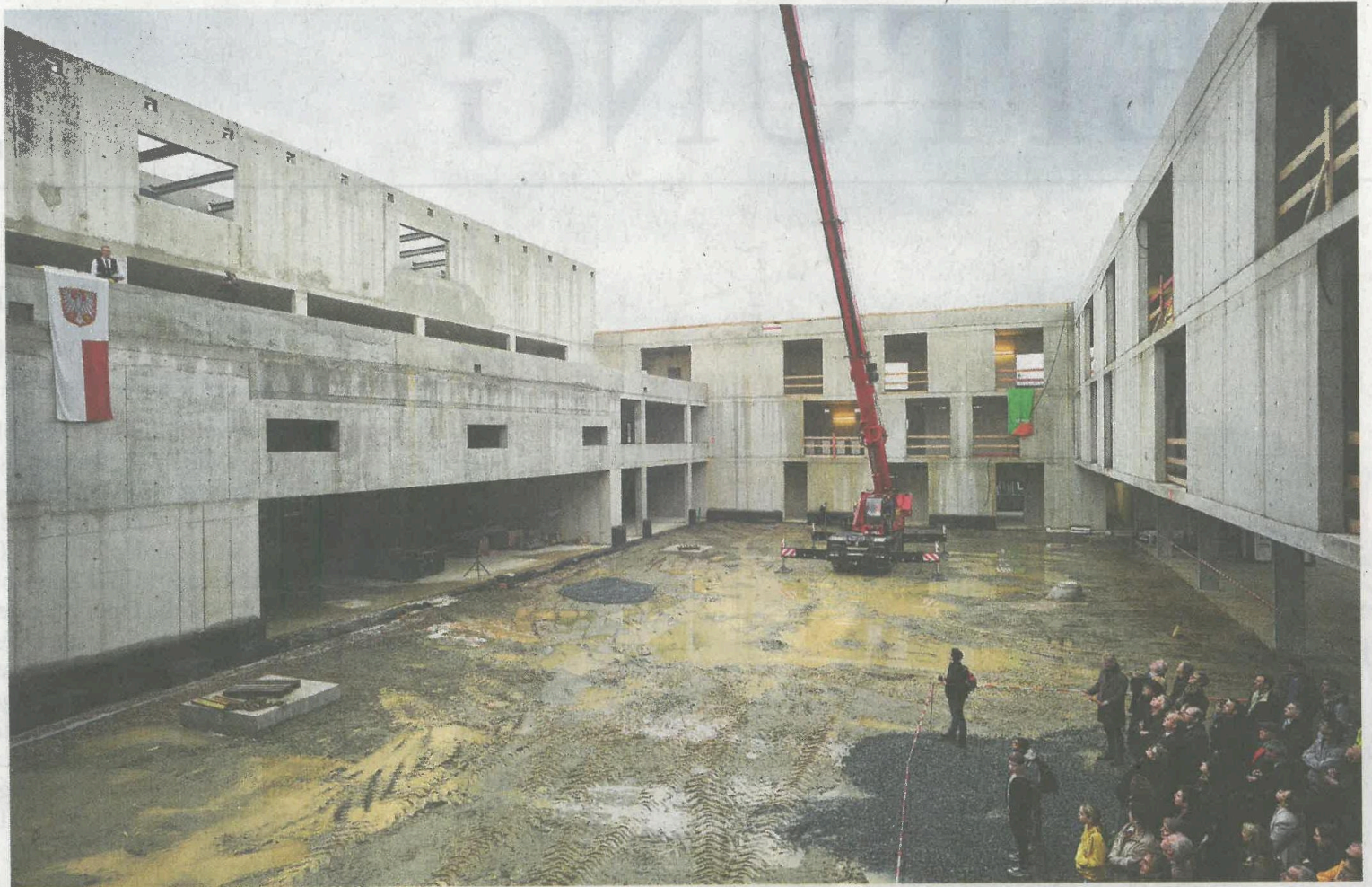
Für Pausen und Feste: der Innenhof. Links die Dachgalerie, rechts ein Durchgang zu den außen liegenden Freiflächen. Foto Röth
